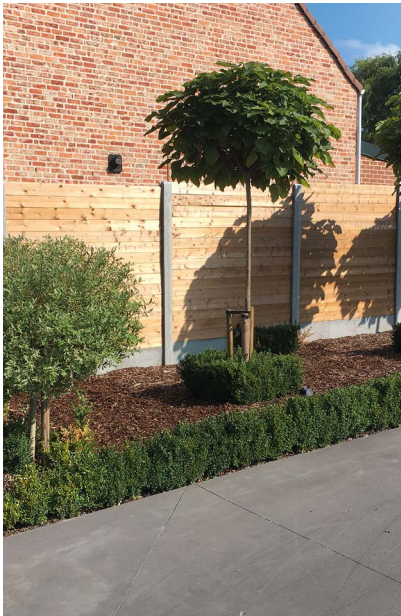
Clôture massive en pin avec poteaux et plaques en béton
